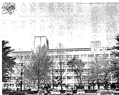
基礎医学研究棟
