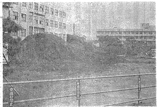
圖書館建設現場
