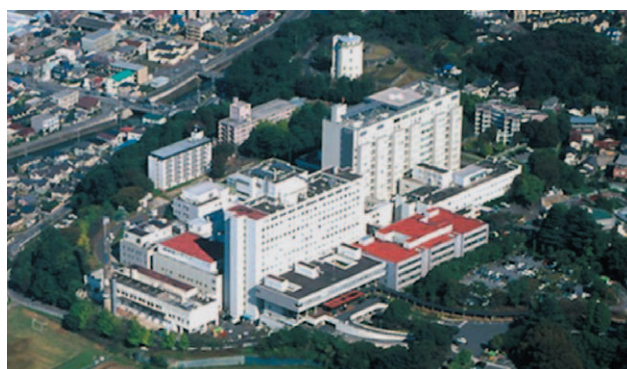
2008年(平成20年)附属病院新病棟竣工
